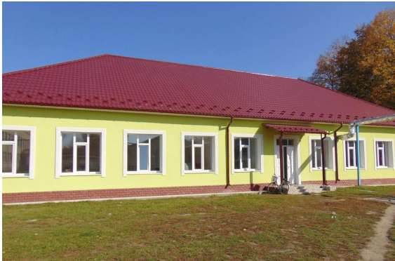
Капітальний ремонт майстерні Мамалигівської ЗОШ I-III ступенів
